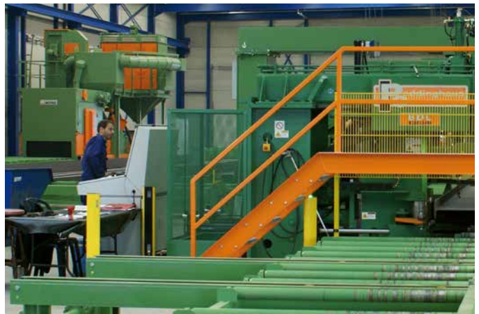
Ansicht der kompletten Linie mit Säge-, Bohr- und Strahlanlage
